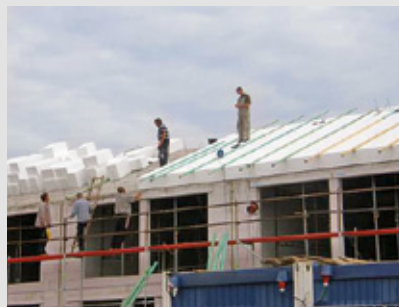
Masivní střecha z betonových dílců, tepelná izolace z polystyrenu (Centrum pasivního domu)
