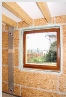
Parobrzdá a zároveň vzduchotěsnící vrstva z OSB desek na interiérové straně stěn dřevostavby. Dobře jsou patrné vzduchotěsné a parotěsné pásky přelepené spoje OSB desek a parotěsné napojení na rám okna (ENVIC, o.s.)
