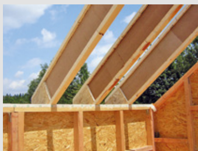
Nosná konstrukce střešy z I – nosníků, prostor mezi I nosníky bude vyplněn tepelnou izolací (Štefan Čanda)
