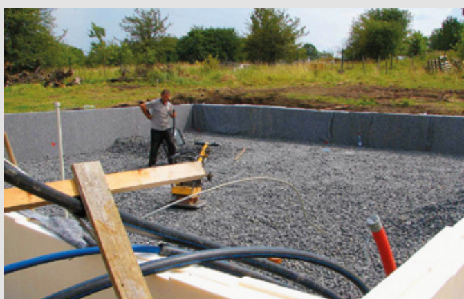
Tepelná izolace z drceného pěnového skla – na ní bude vytvořena betonová základová deska (Kalksandstein CZ s.r.o.)
