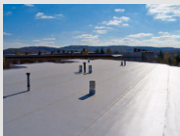
Plochá střecha s povlakovou fóliovou hydroizolací (Izoltec)
