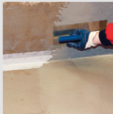
Aplikace hydroizolační stěrky (Soudal)
