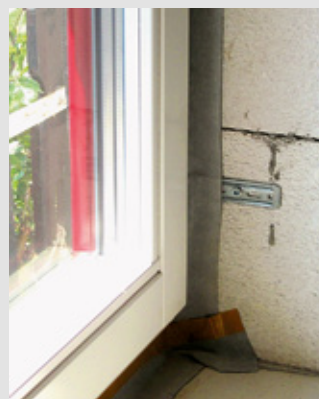
Vnitřní parotěsná a vzduchotěsná okenní páska na zděné stavbě. Zajišťuje vzduchotěsnost osazovacích spár oken a je napojena na vnitřní omítku (ENVIC, o.s.)
