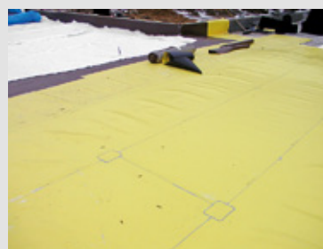
Aplikace fóliové hydroizolace (Fatra, a.s.)
