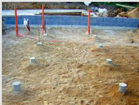
Připravené piloty před montáží dřevěné konstrukce dřevostavby (Aleš Brotánek)
