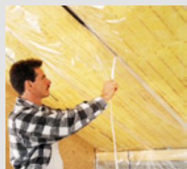
Parozábrana z plastové fólie. Spoje pásů parozábrany musí být těsně slepeny pomocí speciálních pásek (Saint-Gobain Isover CZ s. r. o.)
